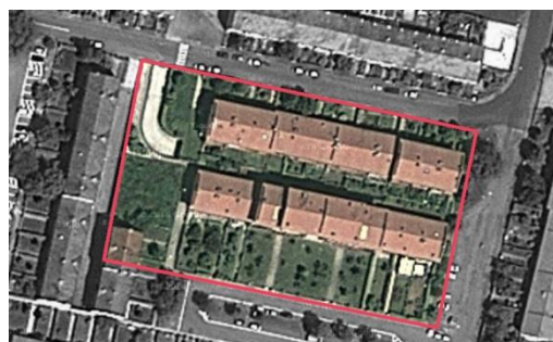
Figura 28 _ Isolato del quartiere Vallone.
